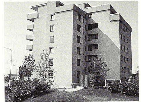
Die 1972 erstellte Überbauung Brunnacher in Brüttisellen
