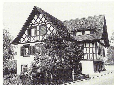
Das Arbeitsheim Wangen an der Hegnaustrasse 28.
