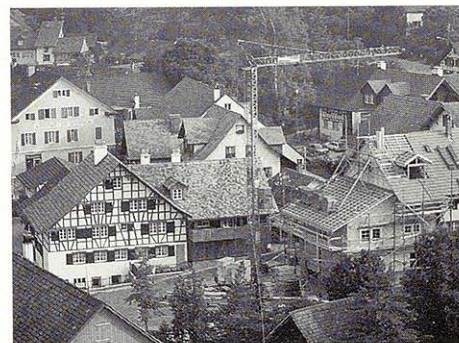
Renovation und Umbau Holzrai 1 und Neubau Holzrai 2 in Wangen
