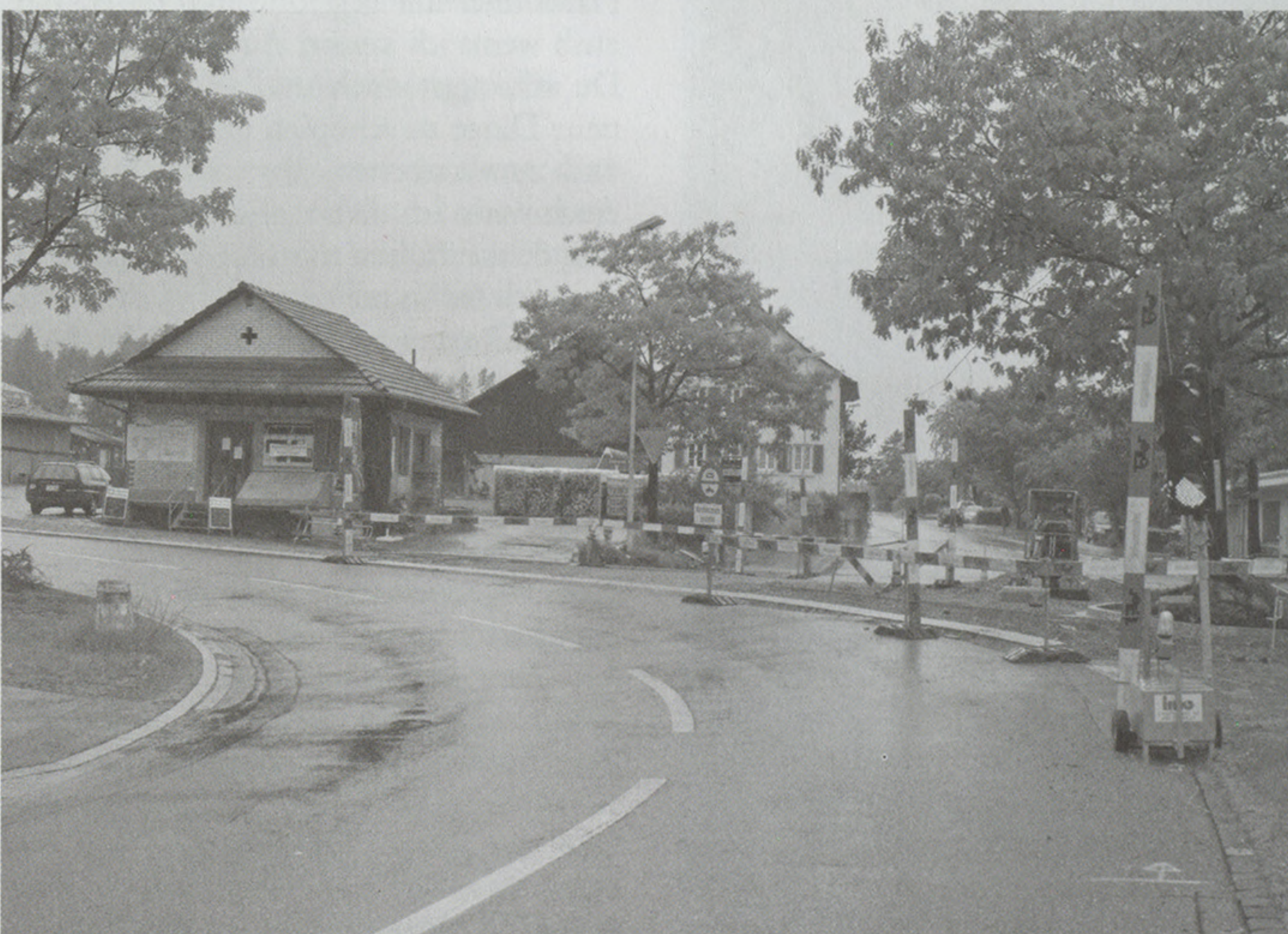
Binz muss wegen Bauarbeiten teilweise umfahren werden, weil hier die Einmündung Zürich-/Zollikonstrasse neu gestaltet wird. Es gibt ein neues, durchgehendes Trottoir. (Foto: sl)
