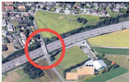
Lage der Brücke Obere Wangenstrasse über die Autobahn.
