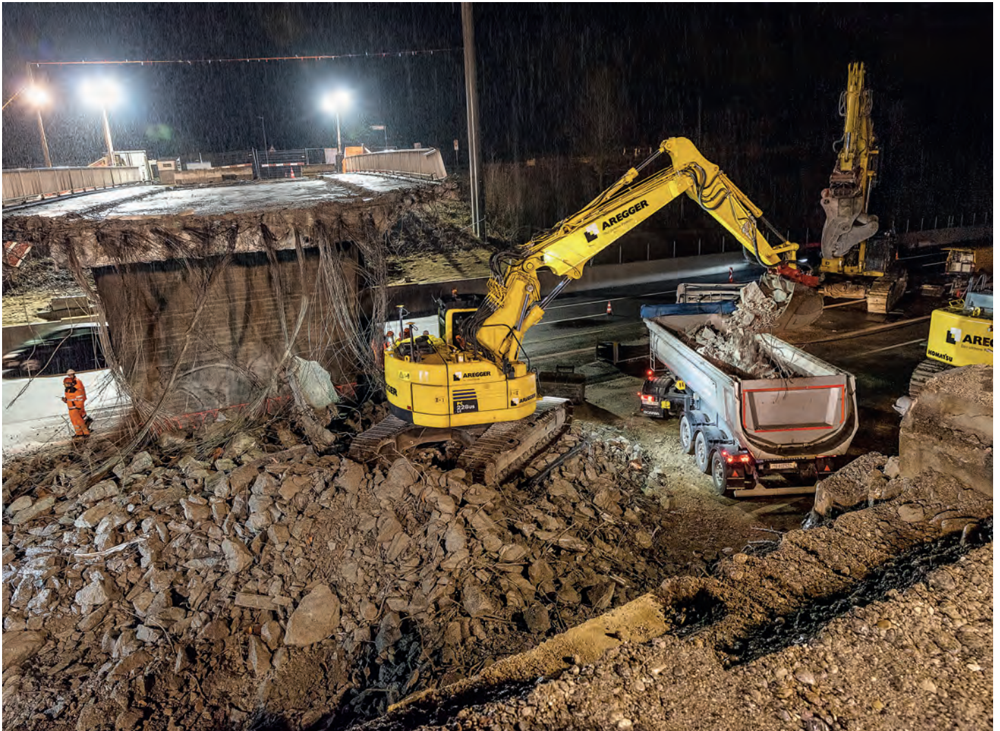
Spektakulärer Abbruch der Brücke der Oberen Wangenstrasse über die Autobahn in der Nacht vom 9. auf den 10. März 2019. Die Autobahn musste während zwei Stunden vollständig gesperrt werden.
