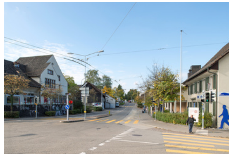
Hauptverkehrsachse vor der Sanierung: Witikonerstrasse 2017 (Bild: HAL_007829, Juliet Haller)
